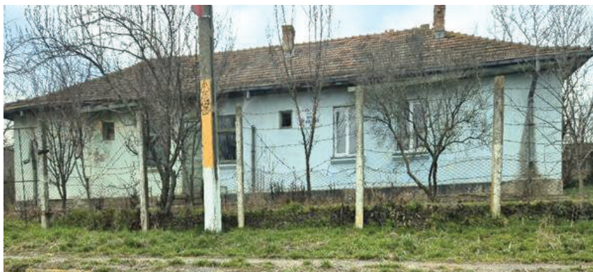
Dispensarul veterinar Găgești construit în 1974
