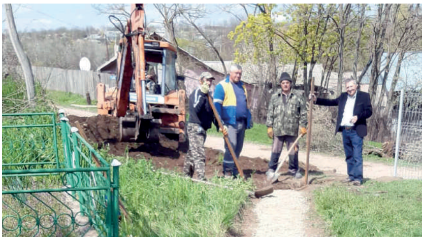
Fotografie de la construcția gardului cimitirului, 2021
